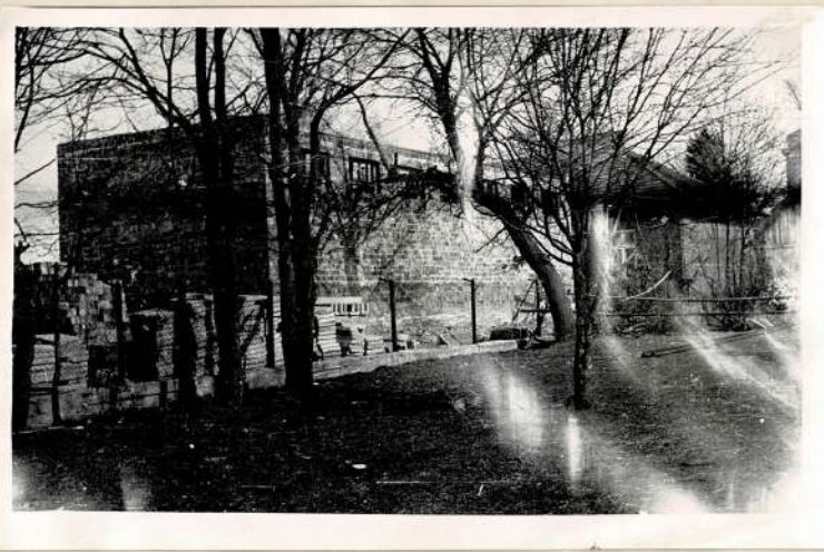
Hala gimnastyczna w budowie.
